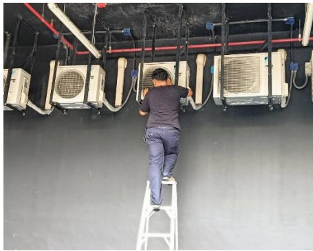
รูปที่ 2.1 ทำความสะอาดเครื่องปรับอากาศ
