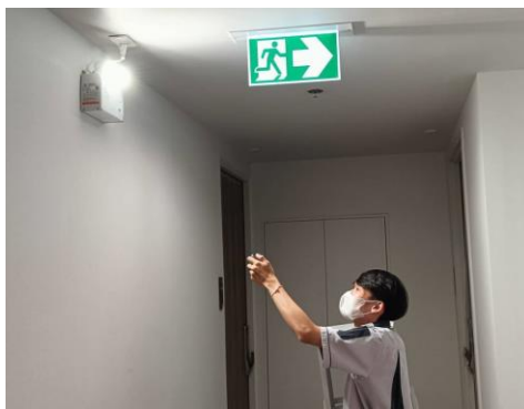
รูปที่ 2.2 ตรวจสอบระบบไฟฟ้าฉุกเฉิน (Emergency Light)
