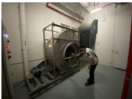
รูปที่ 2.11 ตรวจเช็คพัดลมอัดอากาศ
